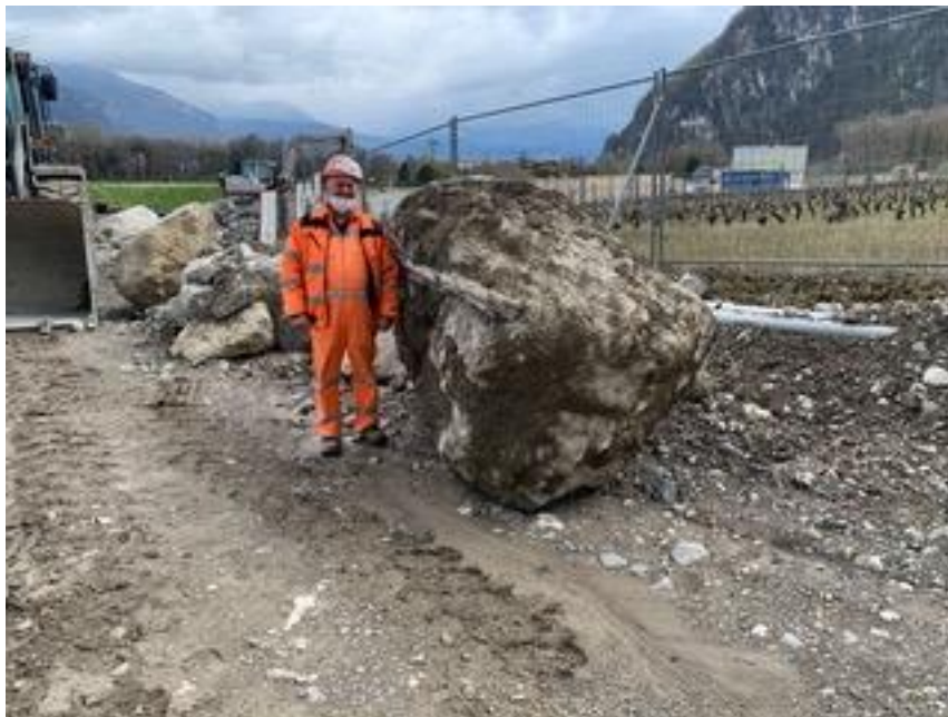
Un ouvrier aux côtés d'un bloc sorti du portail Sud
