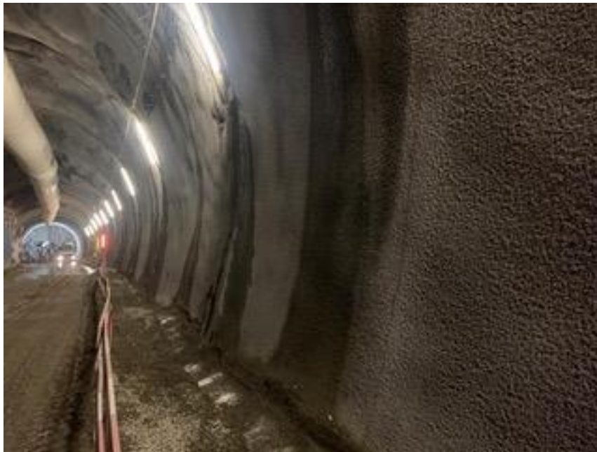
Intérieur du tunnel, côté nord
