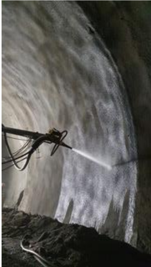
Remplissage des redents avec du béton projeté au portail Nord
