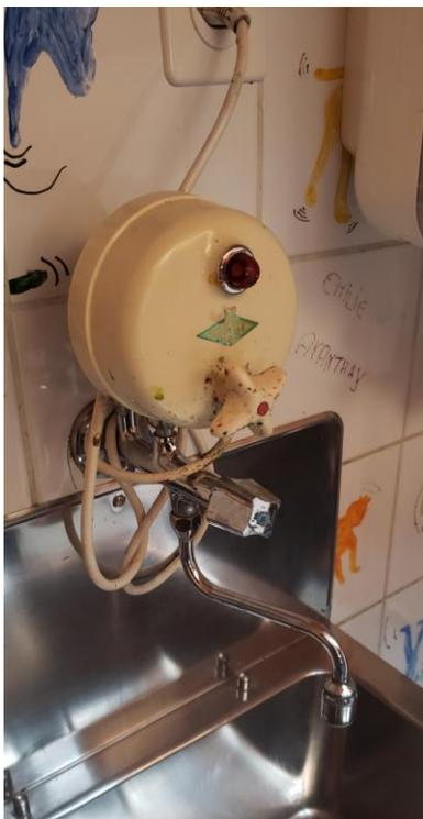
Exemple de chauffe-eau électrique décentralisé (peu courant)
